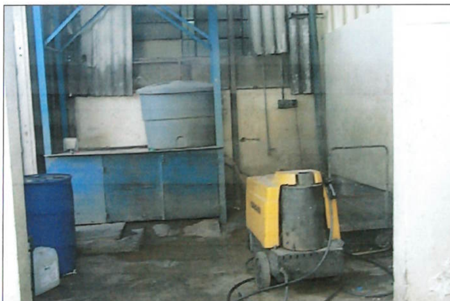
Figura 2 - Fotografia da cabine de lavagem.
